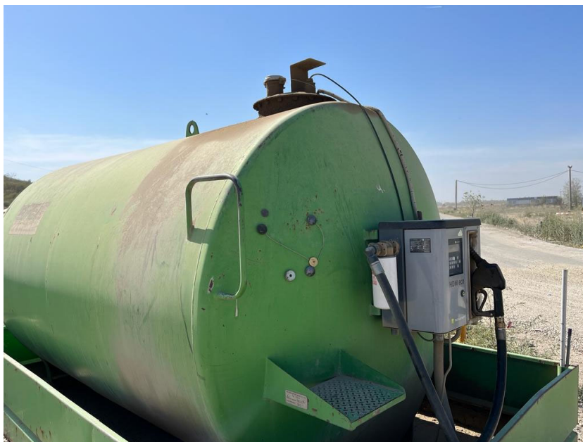
Figura nr. 2-5 Stație de alimentare cu carburanți
