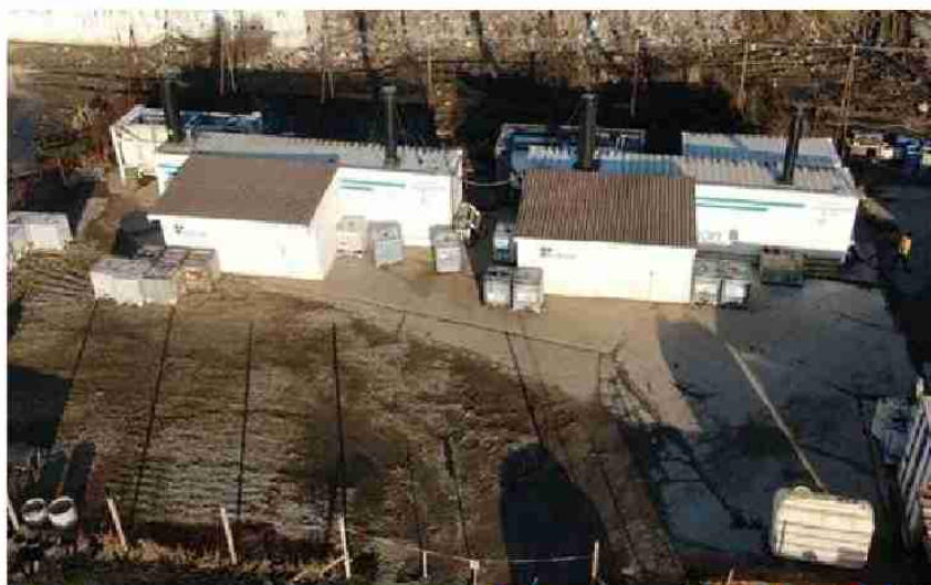
Figura nr. 4-1 Stația de epurare levigat
