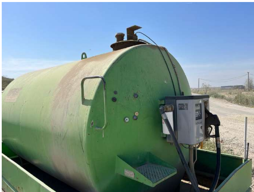
Figura nr. 2-5 Stație de alimentare cu carburanți
