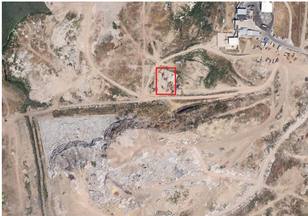
Amplasamentul platformei concasorului mobil
