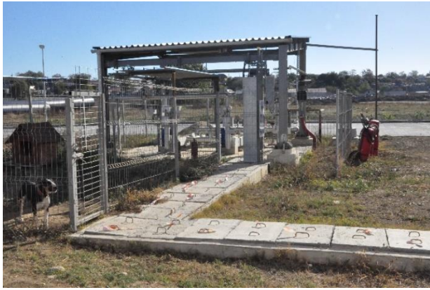
Zona rezervorului subteran de motorină
