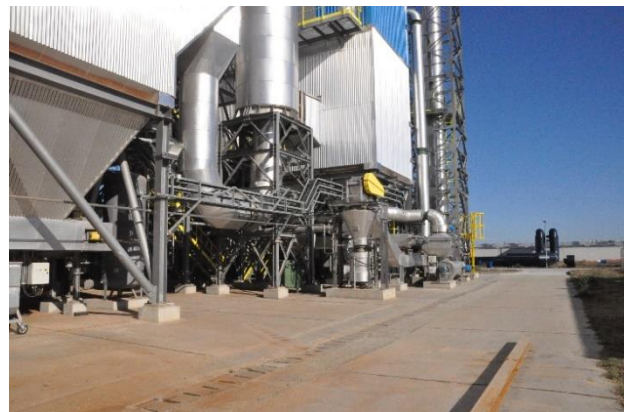
Reactorul de contact și filtru cu saci
